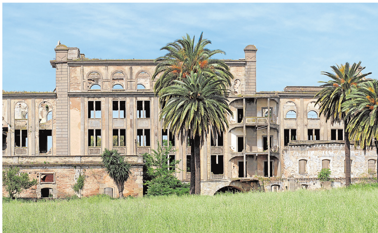
Estado actual de la Fábrica de Harinas, Electricidad y Tejidos de Peñaflor
